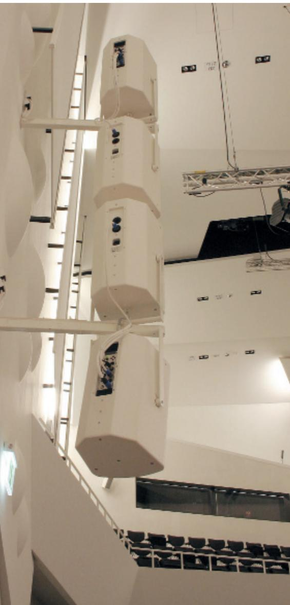
**Die aktiven AT-40 versorgen die Flugbässe ASTP-30 mit verstärkten Signalen**
