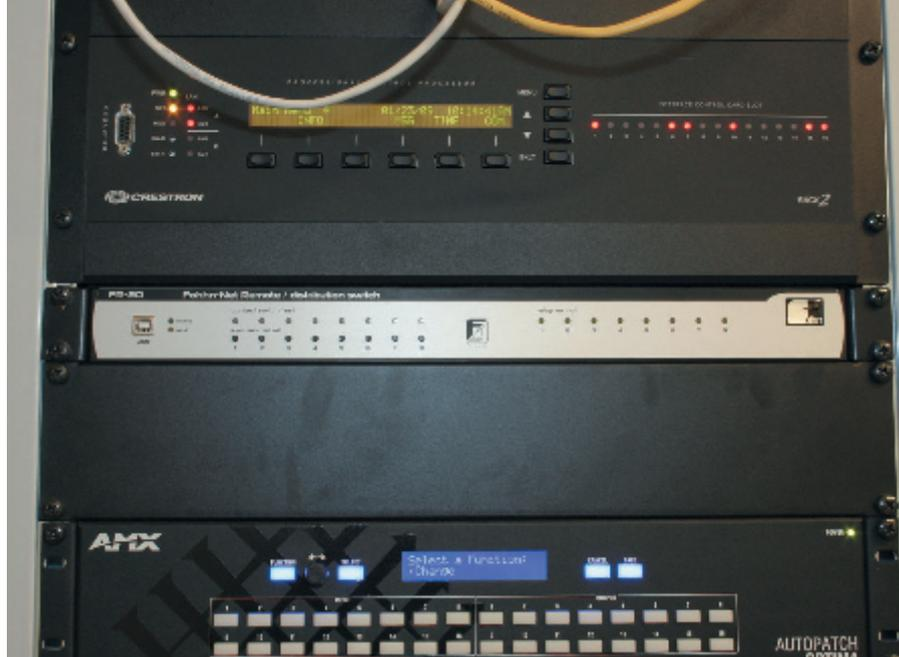
FR-20 Fohhn-Net Fernsteuerungseinheit zur Anbindung an die Mediensteuerung
